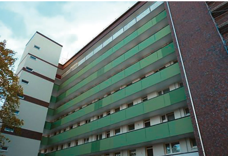
Der erste Bauabschnitt am Heidrehmen ist abgeschlossen und an der Hausnummer 29 kommt die neue Fassade in attraktiver Optik zum Vorschein
