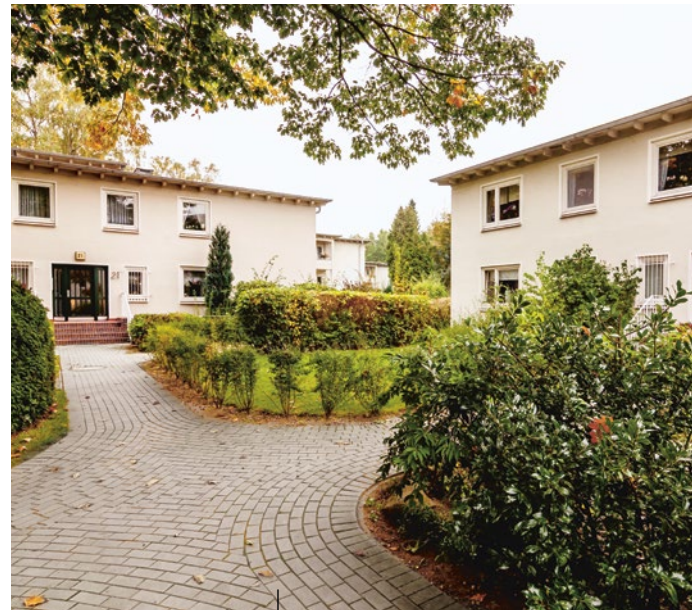
Alle packten mit an, als in den 1950er Jahren in Rissen die sogenannte Gartensiedlung Mechelnbusch gebaut wurde.
