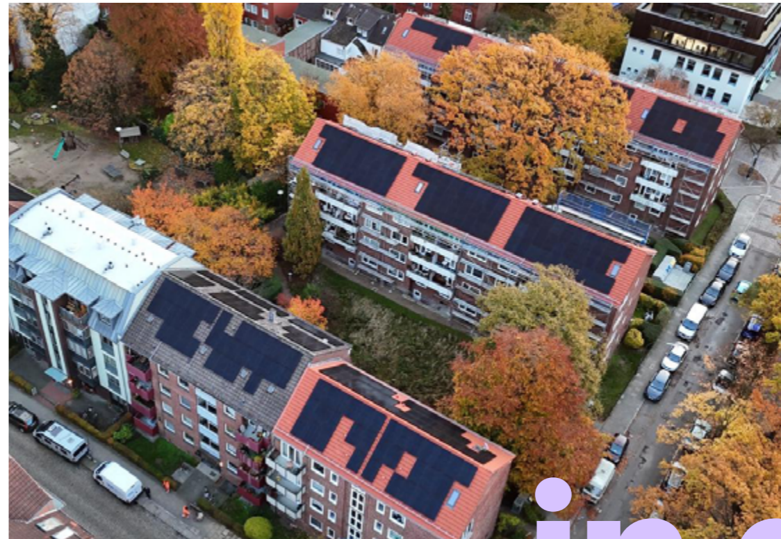
Hospitalstraße Altona PV-Ausbau 2025
