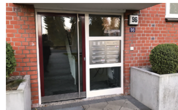
Hauseingangstüranlage Am Botterberg 96 mit neuer Briefkastenanlage und neuem Klingeltableau
