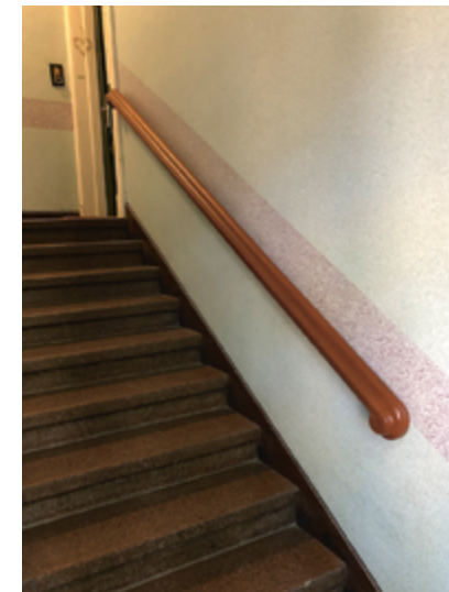
Nachbildung eines historischen Holzhandlaufs im Treppenhaus in der Grünebergstraße
